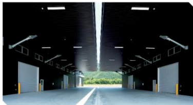
全天候型バンニング・デバンニング対応営業倉庫 (コンテナヤード付・ドックレベラー完備)や危険物倉庫・天井クレーン付倉庫など、多機能倉庫を設置。
